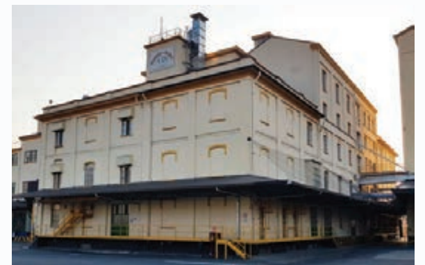
LA SEDE DI MUNDIRISO, LA SOCIETÀ CHE HA COMMISSIONATO A SAMSÒ L'IMPIANTO FOTOVOLTAICO DA 320 KWP SULLE COPERTURE DI UN'AREA RECENTEMENTE ACQUISITA
