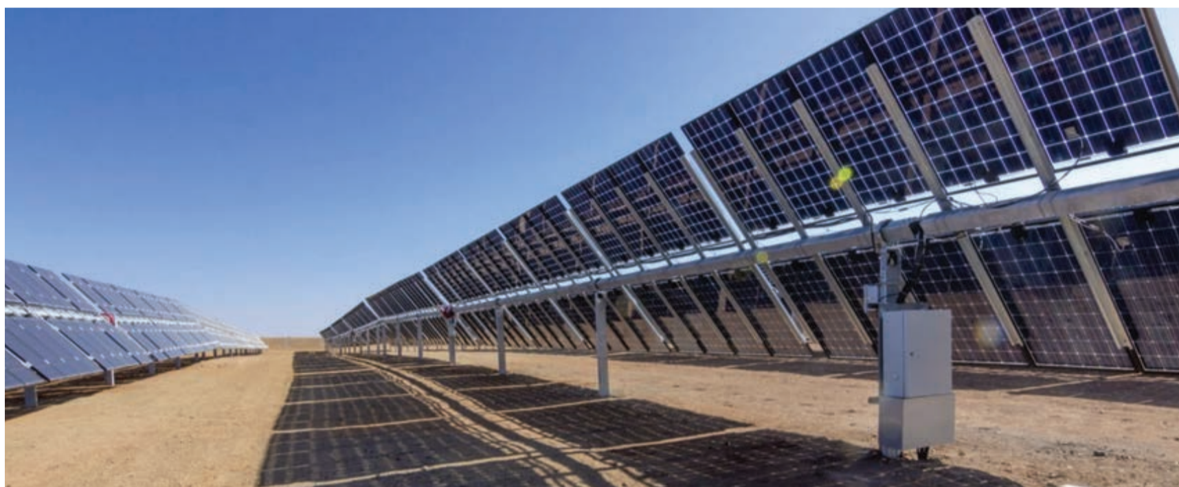
ESSENDO PRINCIPALMENTE RICHIESTI NEI GRANDI PROGETTI FOTOVOLTAICI, OGGI I MODULI BIFACCIALI PIÙ UTILIZZATI SONO QUELLI AD ALTA POTENZA ED ELEVATA EFFICIENZA. IN PARTICOLARE SONO PREMIATI I MODULI CHE UTILIZZANO WAFER M10, E QUINDI DA 182X182 MILLIMETRI, CHE POSSONO PORTARE LA POTENZA DEL PANNELLO INTORNO AI 545 WP SULLA PARTE FRONTALE
