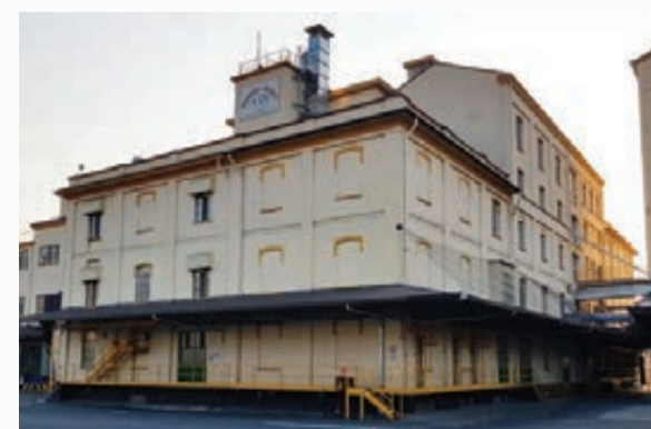
LA SEDE DI MUNDIRISO, LA SOCIETÀ CHE HA COMMISSIONATO A SAMSÒ L'IMPIANTO FOTOVOLTAICO DA 320 KWP SULLE COPERTURE DI UN'AREA RECENTEMENTE ACQUISITA
